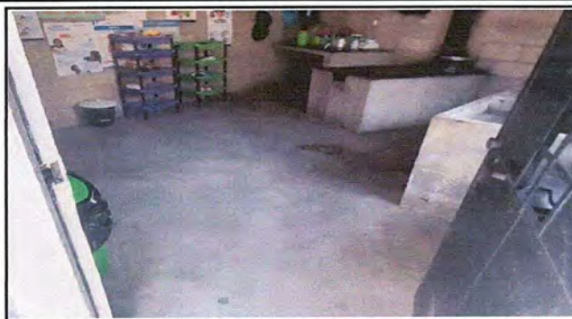
Foto 2: MODULO 1 Sustitución de piso de torta de concreto por piso cerámico
