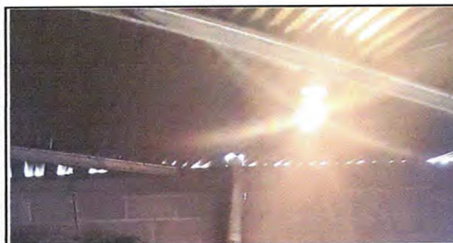
Foto 5: MODULO 1 Sustitución de lamparas tipo LED
