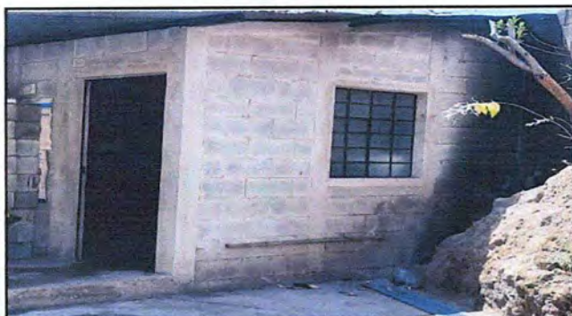
Foto 3: MODULO 1 suministros e instalación de balcones
