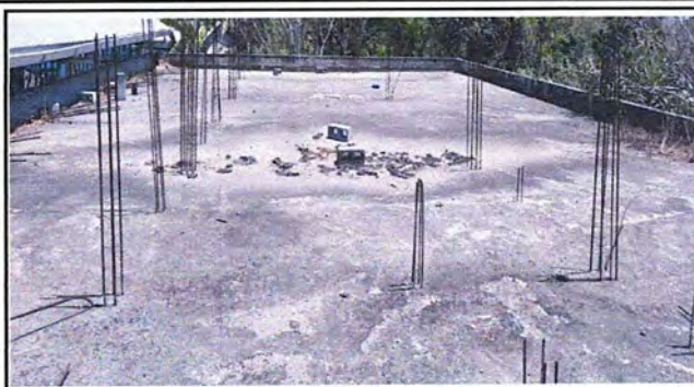
foto 14: MODULO 2 impermeabilización de losa
