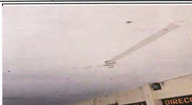
Foto 13: MODULO 2 sustitucion de lampara LED
