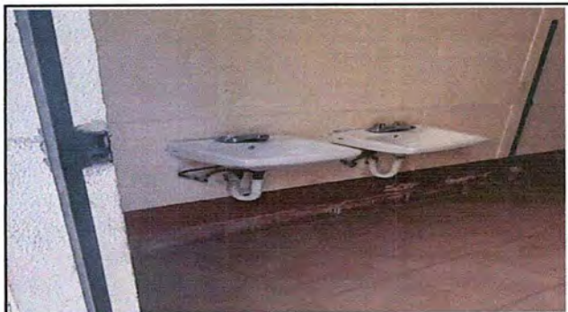
Foto 10:MODULO 2 Sustitución lavamanos
