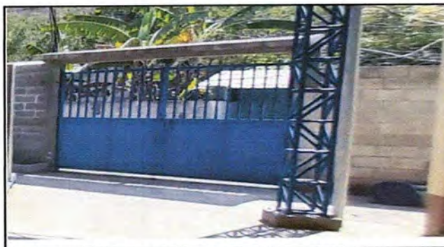
Foto16 MURO PERIMETRAL: Mantenimiento a portones de metal
