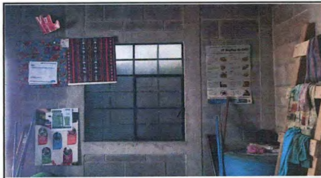
Foto 4: MODULO 1 repello de muro
