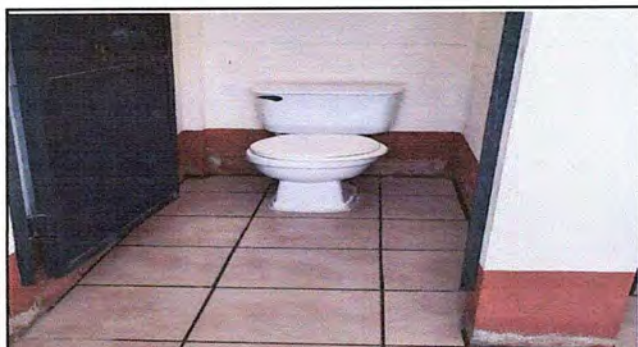
foto 9: MODULO 2 Sustitución inodoro
