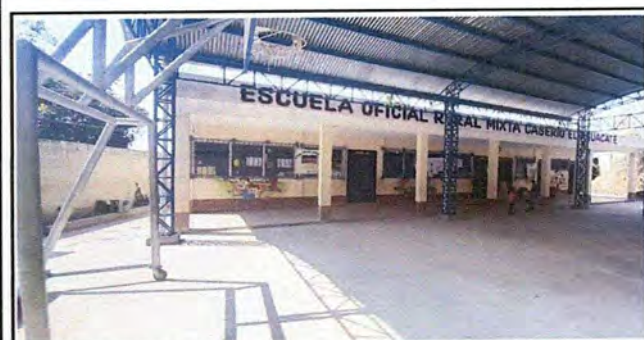
Foto 17: PINTURA GENERAL pintura en muros exteriores e interiores
