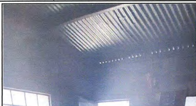
Foto 7 MODULO 1 foto 8: Sustitucion de estructura de soporte de metal
