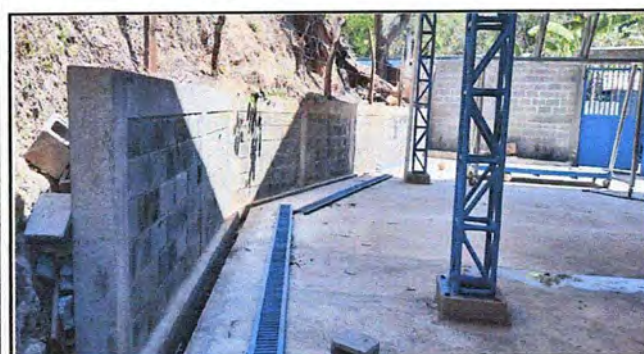
Foto15: MURO PERIMETRAL repello en muro
