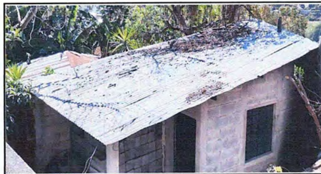
Foto 6: MODULO 1 Sustitución de lámina, por lámina troquelada aluzinc calibre 26
