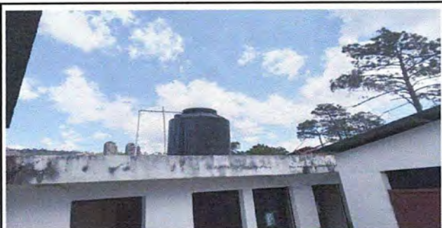
Foto 5: MODULO 3: Sustitución de deposito de agua 1100 lt
