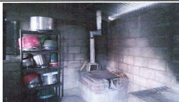
Foto 2: MÓDULO 1: Sustitución de estufa rural (completa) incluye chimenea y plancha de metal
