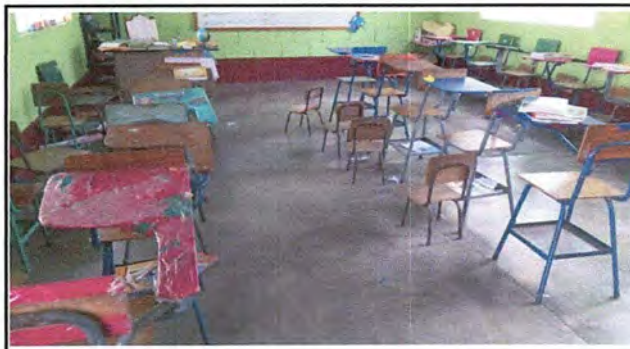
Foto 11: MÓDULO 5: Sustitución de piso de torta de concreto por piso cerámico
