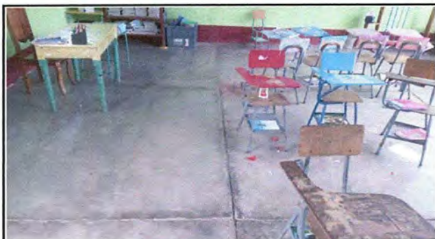
Foto 9: MÓDULO 4: Sustitución de piso de torta de concreto por piso cerámico
