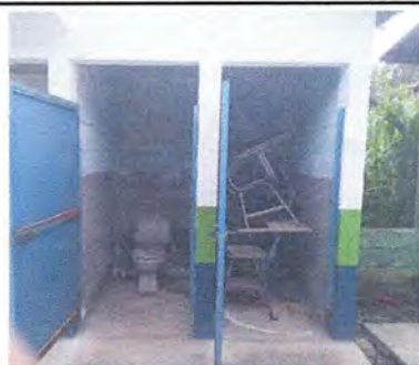
Foto 7: MODULO 3 Mantenimiento a estructura de puerta (lijado, cambio de tubo , cepillado, sujeciones, aplicación de pintura) a puertas servicios sanitarios
