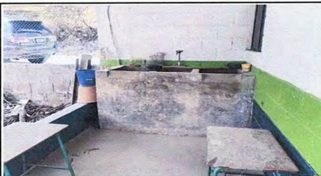
Foto 3: MÓDULO 1: reparación de pila de concreto
