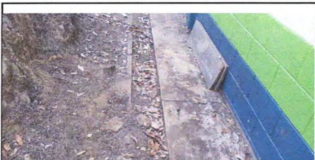
Foto 9: MODULO 1 Reparación de cuneta de concreto
