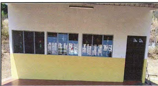
Foto 12: MODULO 2 Suministro e instalación de balcones de metal
