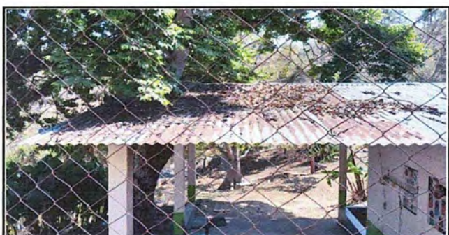
Foto 5: MODULO 1 Sustitución de lámina, por lámina troquelada aluzinc calibre 26
