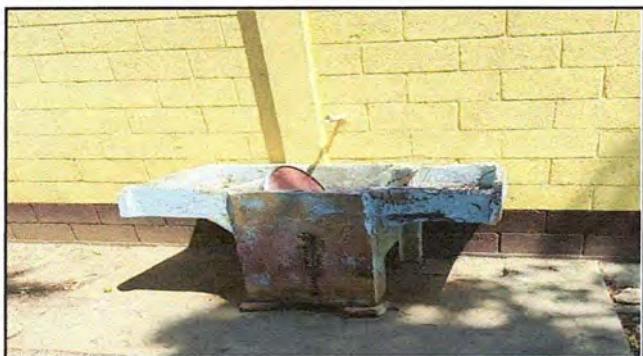
Foto 3: MODULO 1 Sustitución de pila de cemento de dos lavadero
