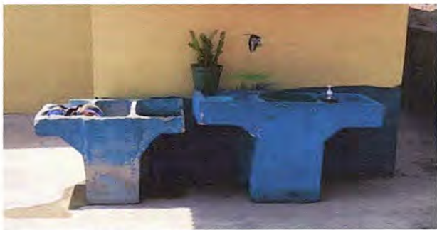
Foto 13: MODULO 2 Sustitución de pila de cemento de dos lavadero
