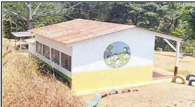
Foto 10: MODULO 2 Sustitución de lámina, por lámina troquelada aluzinc calibre 26
