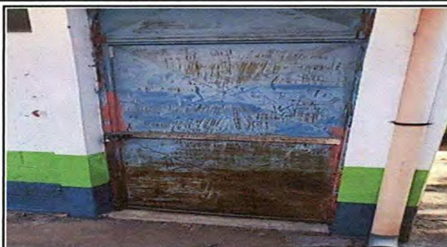
Foto 7: MODULO 1 Mantenimiento a estructura de puerta (lijado, cambio de tubo, cepillado, sujeciones, aplicación de pintura)
