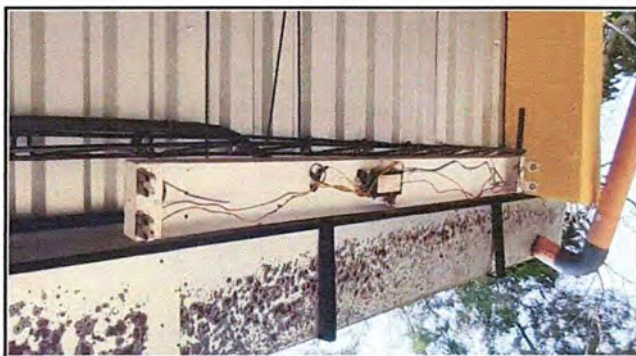
Foto 4: MODULO 1 Sustitución de lamparas tipo LED
