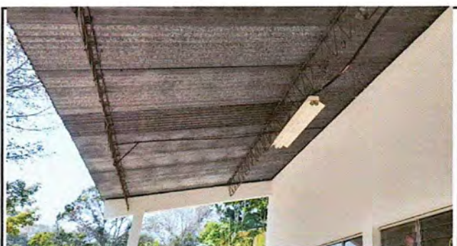
Foto 11: MODULO 2 Mantenimiento a estructura de soporte de metal
