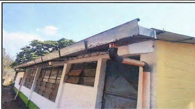
Foto 2: MODULO 1 Sustitución de canal de metal
