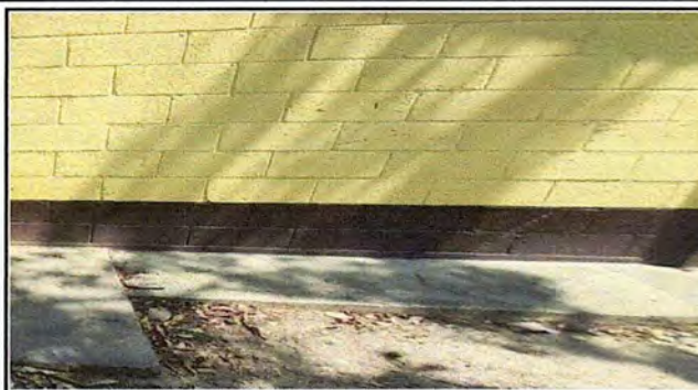
Foto 8: MODULO 1 Reparación de banquetas de concreto
