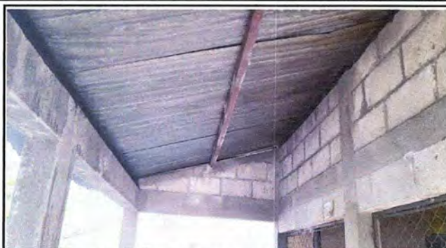
foto 8: Sustitucion de estructura de soporte de metal por metal
