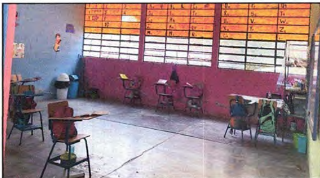
Foto 4: modulo 2 Sustitución de piso de torta de concreto por piso cerámico
