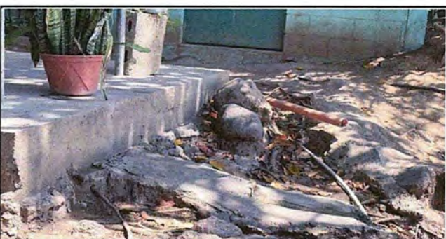
foto 11: LOSA DE PATIO: reparación de cuneta de concreto
