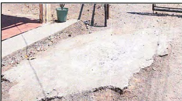
foto 10: LOSA DE PATIO: reparación de plancha de concreto de patio
