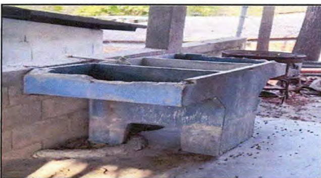
foto 9: sustitución de pila de comento de dos lavaderos
