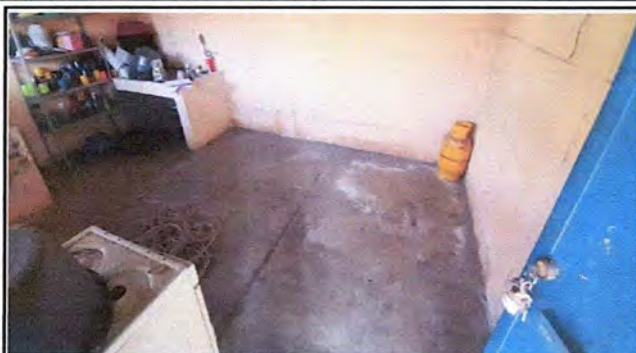
foto 7: sustitucion de piso de torta de concreto por piso cerámico
