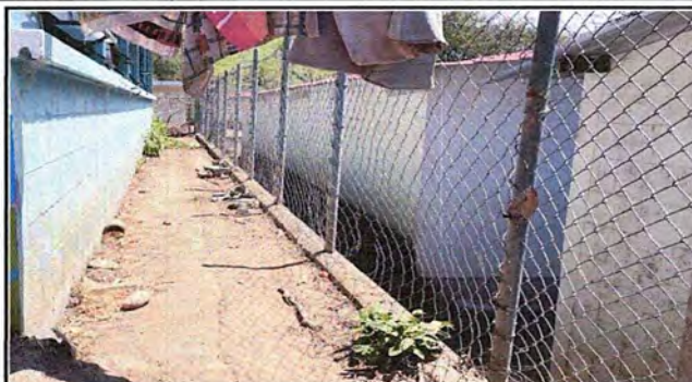
Foto 2: modulo 2 Reparación de cuneta de concreto
