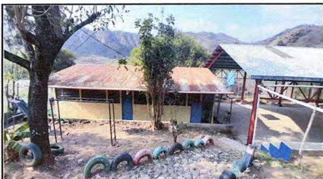
Foto 3: modulo 2 Sustitución de lámina, por lámina troquelada aluzinc calibre 26
