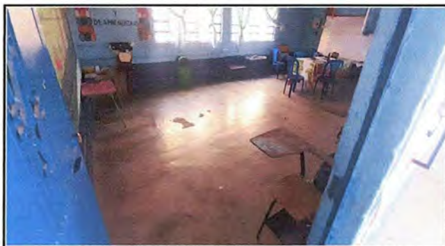
Foto 3: MODULO 1 Sustitución de piso de torta de concreto por piso cerámico
