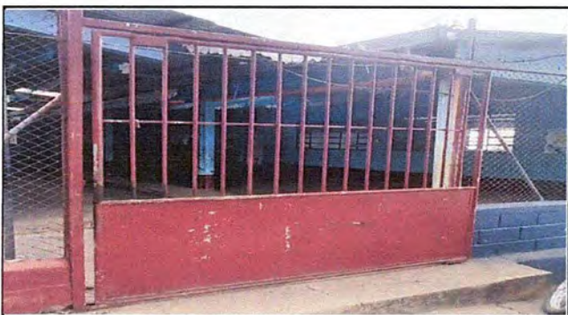
Foto 9: MODULO 2 Mantenimiento a portones de metal
