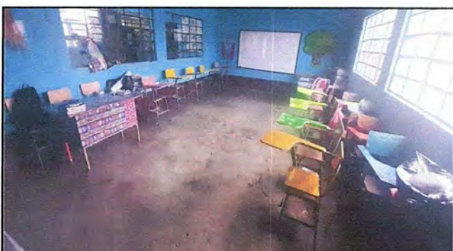
Foto 4: MODULO 2 Sustrución de piso de torta de concreto por piso cerámico
