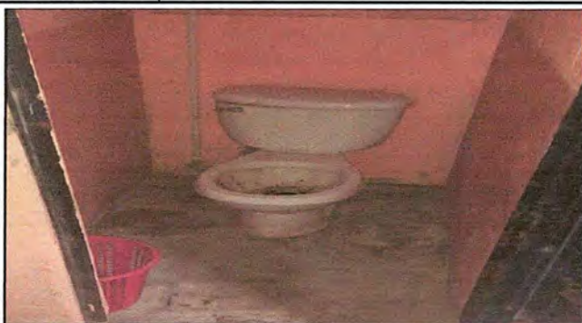
Foto 7: MODULO 2 Sustitución inodoro
