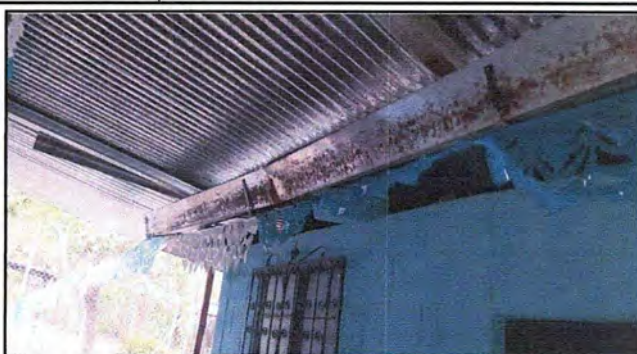
Foto 2: MODULO 1 Sustrución de canal de metal
