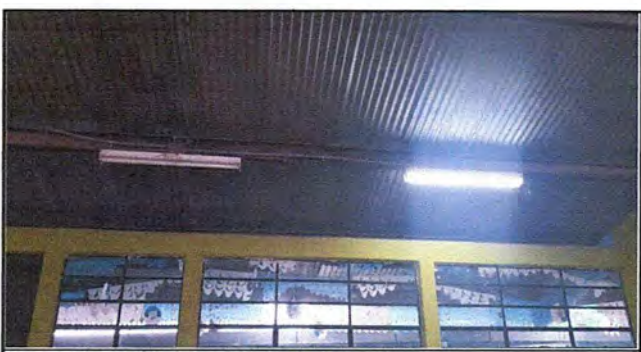
Foto 5: MODULO 2 Sustrución de lamparas tipo LED
