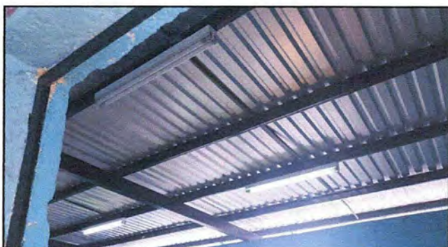
Foto 3: MODULO 1 Sustrución de lamparas tipo LED
