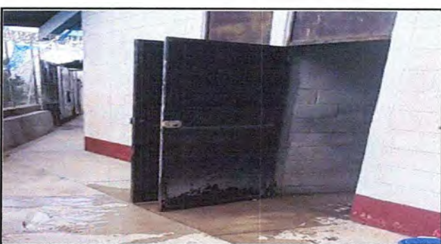
Foto 6: MODULO 2 Mantenimiento a estructura de puerta (lijado, cambio de tubo , cepillado, sujeciones, aplicación de pintura) a puertas servicios sanitarios
