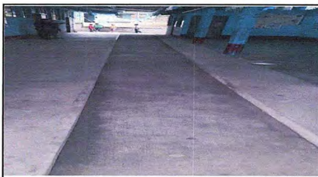
Foto 10: MODULO 3 Reparación de planchas de concreto de patio
