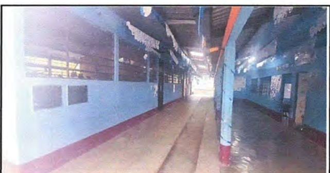
FOTO 11: PINTURA GENERAL. Pintura en muros exteriores e interiores
