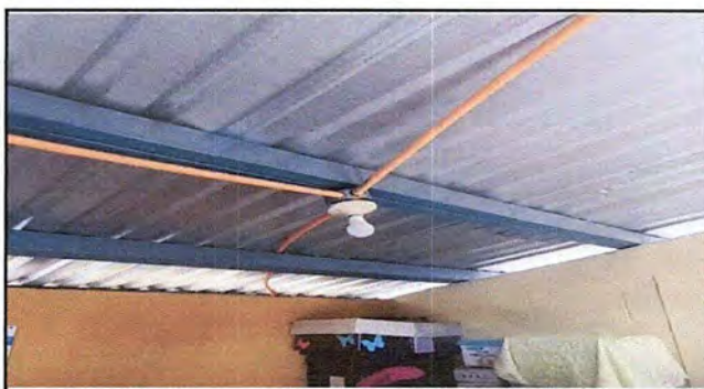
Foto 10: MODULO 2 Sustitución de lamparas tipo LED
