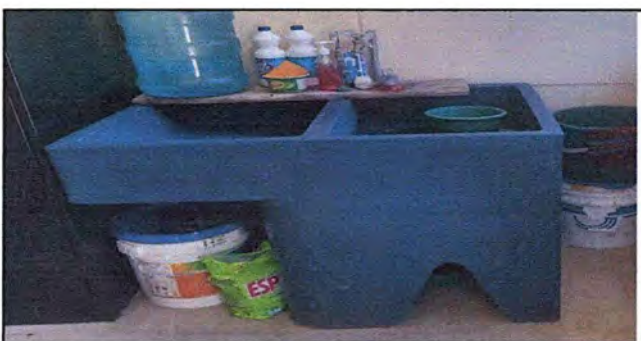
Foto 11: MODULO 2 Sustitución de pila plástica de un lavadero
