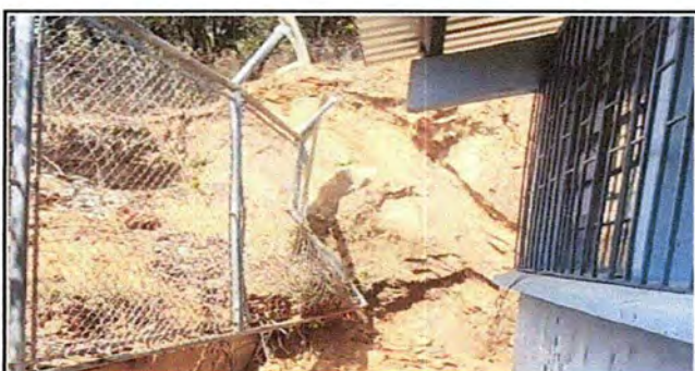
Foto 6: MURO PERIMETRAL Reparación de muro perimetral de block con tubo hg y malla galvanizada, soleras intermedias y columnas
