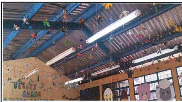
Foto 4: MODULO 1 Sustitución de lamparas tipo LED
