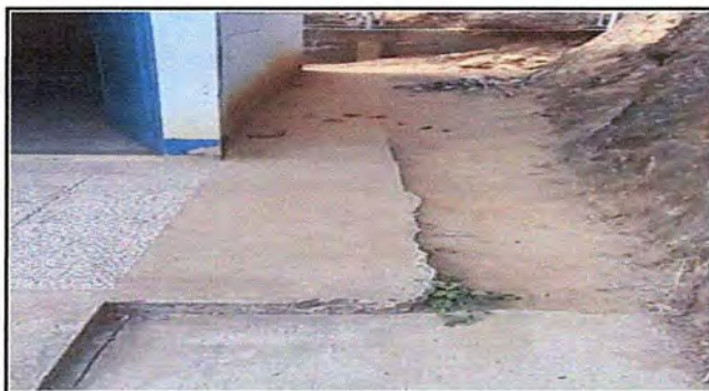
Foto 3: MODULO 1 Reparación de banquetas de concreto
