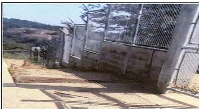
Foto 9: MODULO 2 Reparación de cuneta de concreto
