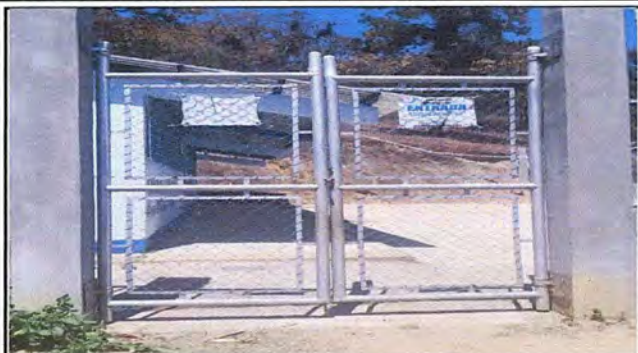
Foto 13: Mantenimiento a portones de metal
