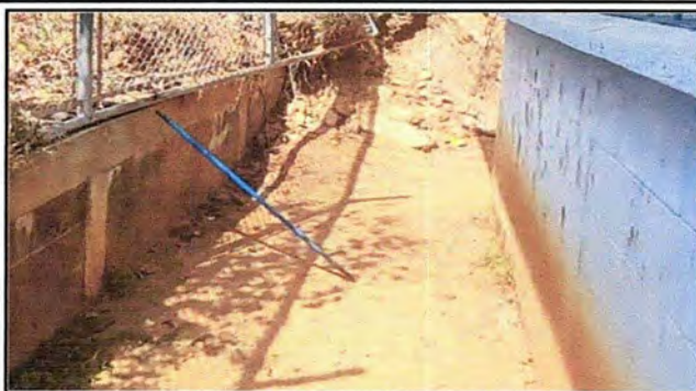
Foto 2: MODULO 1 Reparación de cuneta de concreto
