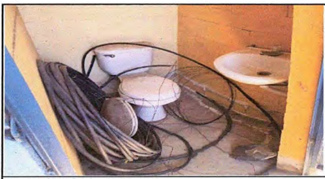
Foto 5: MODULO 1 Sustitución inodoro
