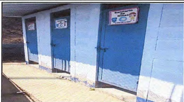
Foto 7: MODULO 1 Mantenimiento a estructura de puerta (lijado, cambio de tubo, cepillado, sujeciones, aplicación de pintura) a puertas servicios sanitarios
