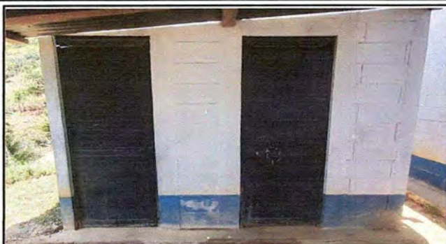
Foto7: MODULO 2 Mantenimiento a estructura de puerta (lijado, cambio de tubo , cepillado, sujeciones, aplicación de pintura) a puertas servicios sanitarios
