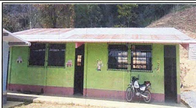
Foto 2: MODULO 1 Sustitución de lámina, por lámina troquelada aluzinc calibre 26
