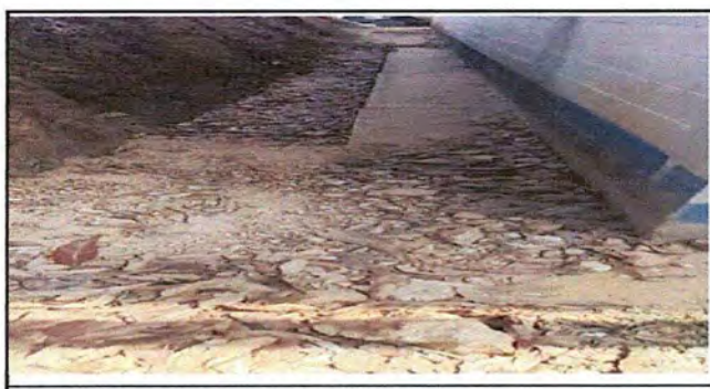
Foto 5: Reparación de cuneta de concreto
