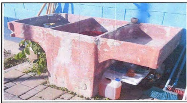
Foto 6: MODULO 2 Sustitución de pila de cemento de dos lavadero
