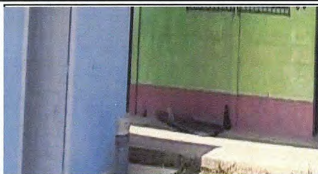
Foto1: MODULO 1 Reparación de planchas de concreto de patio
