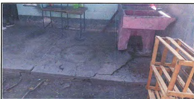
Foto 6: MODULO 2 Sustitución de piso de torta de concreto por piso cerámico
