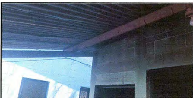
Foto 5: MODULO 2 Sustitución de estructura de soporte de metal, por metal
