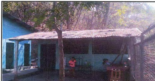
Foto 4: MODULO 2 Sustitución de lámina, por lámina troquelada aluzinc calibre 26
