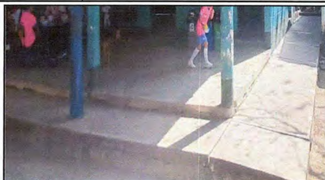
Foto 2: MODULO 1 Reparación de banquetas de concreto
