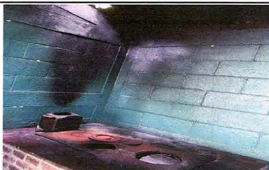
Foto 3: MODULO 2 Sustitución de estufa rural (completa) incluye chimenea y plancha de metal
