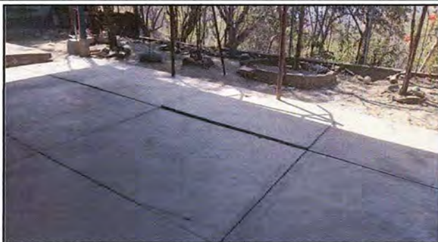
Foto 7 MODULO 3 Reparación de planchas de concreto de patio
