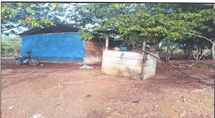
Foto 3: Sustitución de pozo de tubos loza por pozo mecánico
