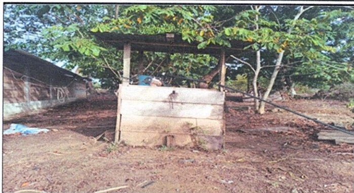
Foto 1: Sustitución de pozo de tubo de loza por pozo mecánico
