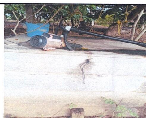
Foto 4: sustitución de bomba periférica
