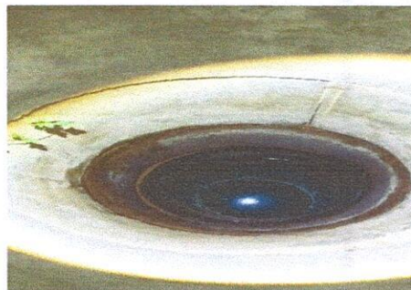
Foto 2: Vista interior del pozo.
