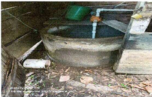
Foto 3: sustitucion de PVC
