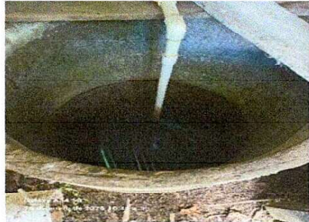
Foto 2: sustitución de tubos
