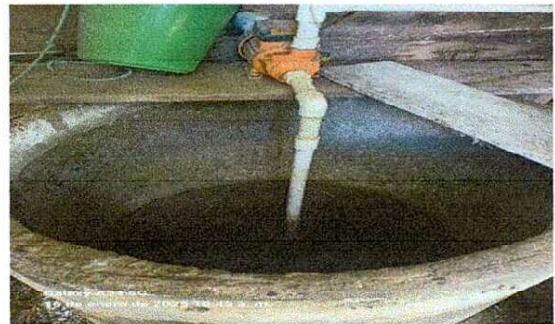
Foto 4: sustitucion de bomba
