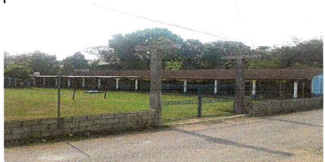
Foto 6: vista del establecimiento de exterior
