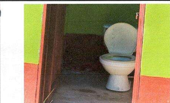
Foto 11: Sustitución de inodoro
