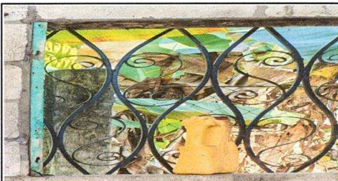
Foto 4: Sustrución de balcones de metal
