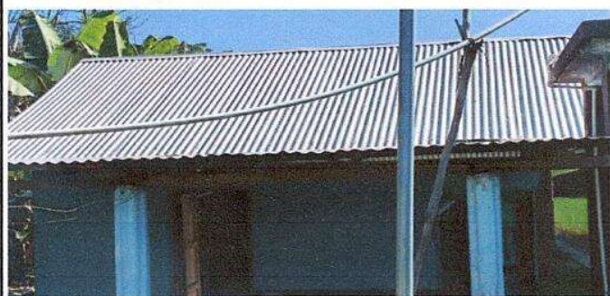
Foto 1: Sustrución de lámina por lámina troquelada aluzinc calibre 26
