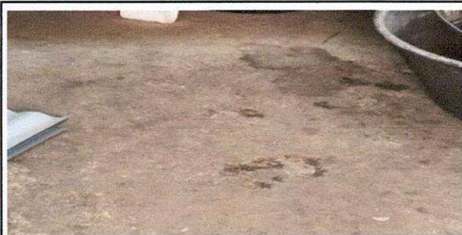
Foto 5: Sustrución de piso de tora de cemento por piso cerámico
