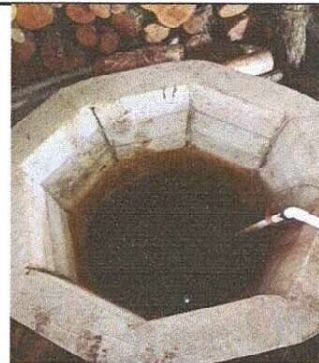
Foto 4: Vista interior del pozo
