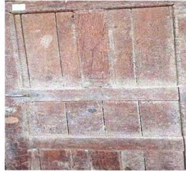
Foto 2: Sustrución de puerta de madera por puerta de metal
