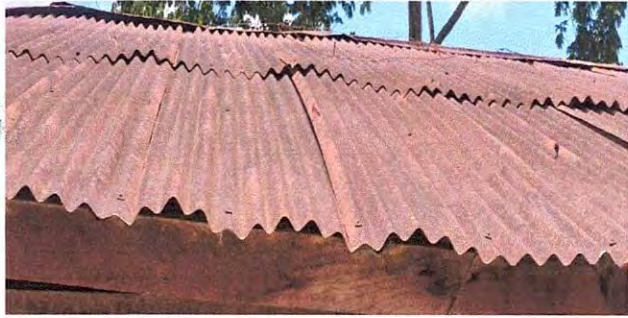
Foto 1: Sustrución de láminas de metal por láminas troquelada
