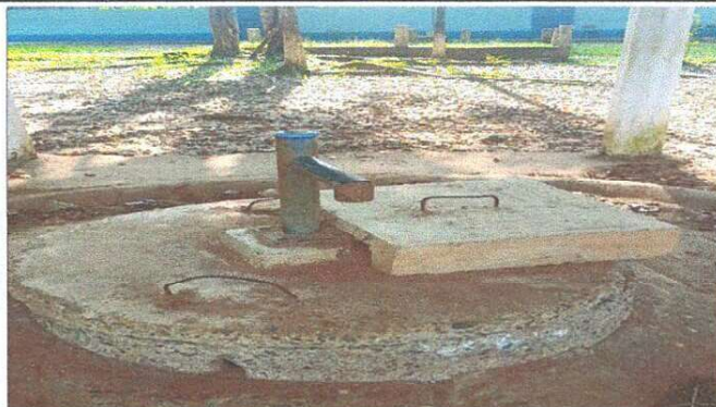
Foto 2: CUBIERTA DE CEMENTO DEL POZO
