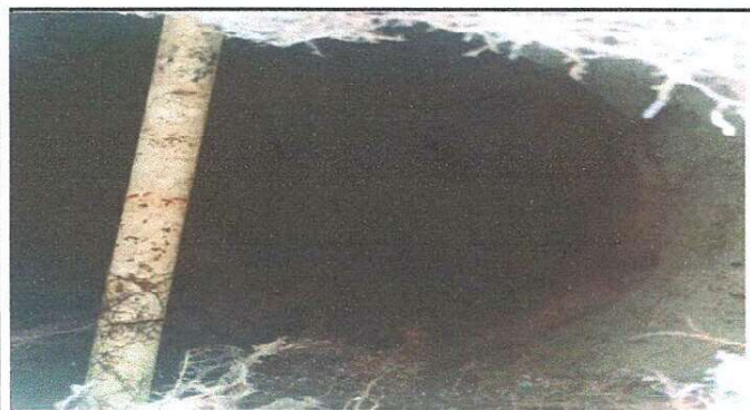
Foto 3: POZO SIN AGUA .
