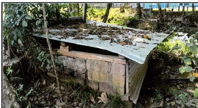
Foto 3: Mantenimiento a pozo
