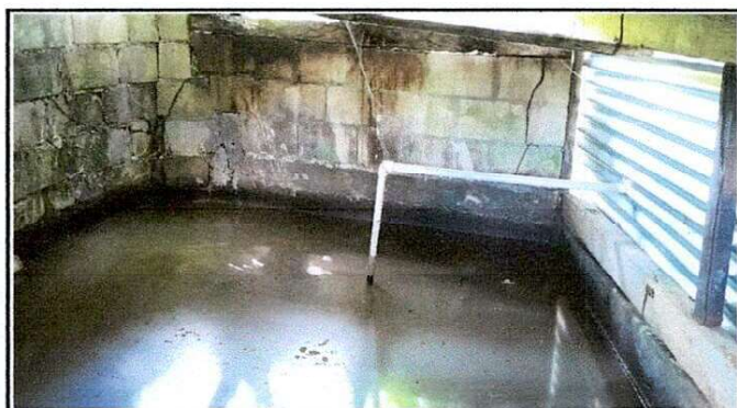
Foto 4: Vista Interior del pozo
