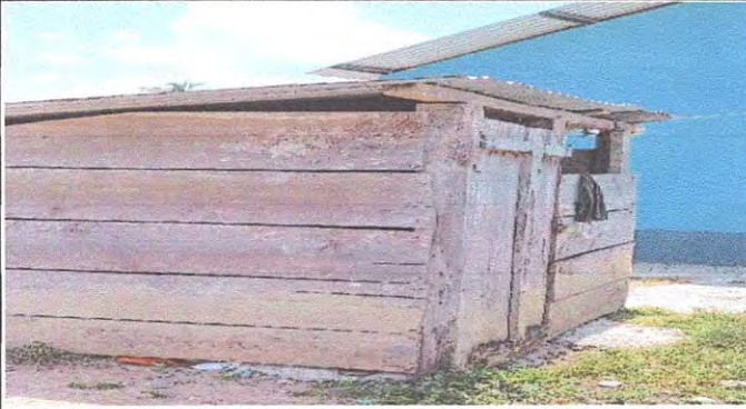
Foto 1: Casa que resguarda el pozo.
