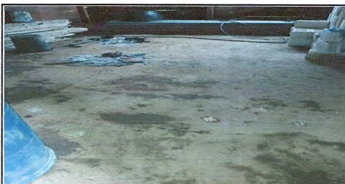
Foto 6: Sustitución piso, torta de concreto
