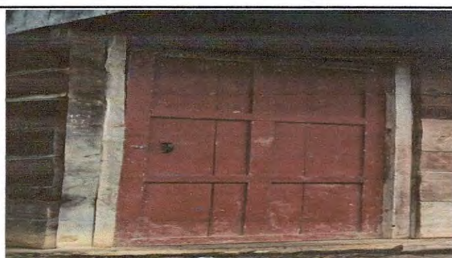
Foto 4: Sustitución de puerta.
