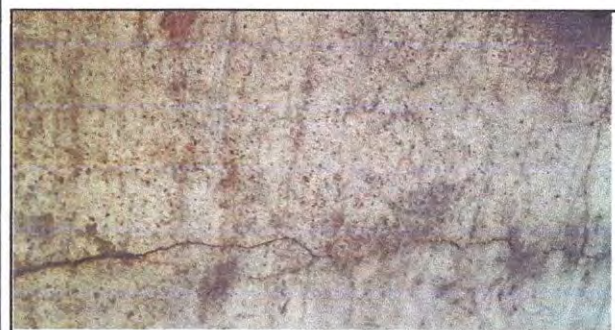
Foto 5: Piso de concreto.
