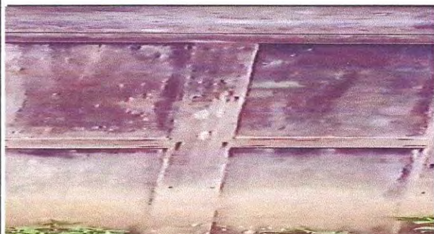
Foto 3: Sustitución de puerta de madera por metal.
