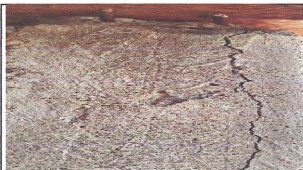
Foto 4: Repello en muro exterior e interior (incluye material y blok)
