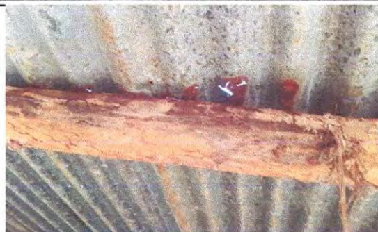
Foto1: Sustitución de lámina, capote y elementos de fijación por lámina troquelada aluzinc cal. 26.
