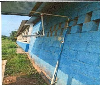
Foto 5: Remozamiento de red de agua para la cocina.
