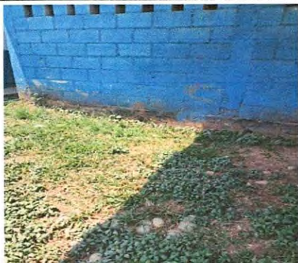
Foto 1: Pintura, se utilizará para remozamiento de la cocina, tanto interiores como exteriores
