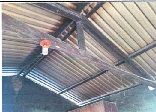
Foto 3: Sustitución de láminas dañadas y cambio de estructura de madera por estructura metálica.
