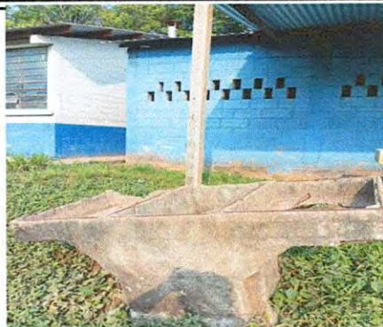
Foto 2: pila para almacenamiento de agua en el interior de la cocina y tinaco para su recepción.
