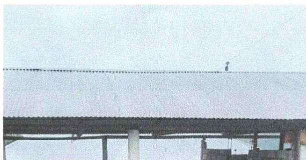
Foto 1: Sustrución de laminas por láminas troqueladas
