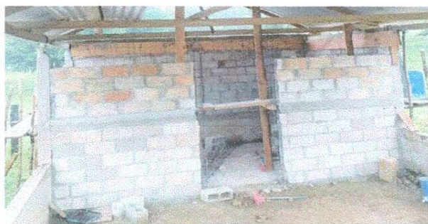
Foto 6: Instalación de puertas de metal
