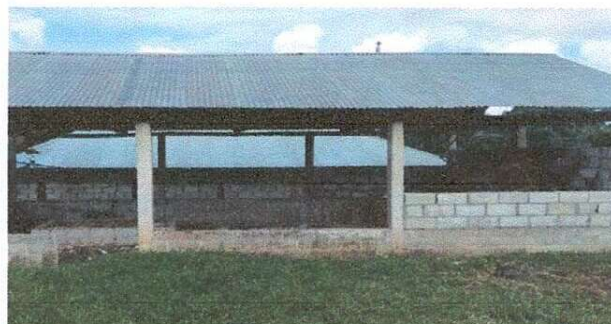
Foto 4: Instalación de balcones
