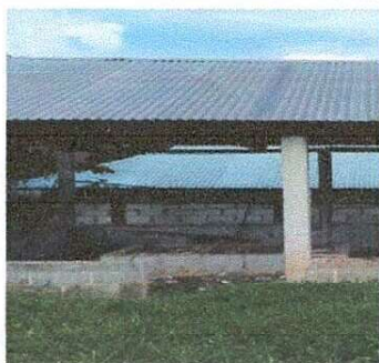
Foto 5: Reparación de muro perimetral
