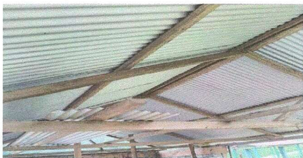
Foto 3: Sustrución de estructuras de soporte de madera por metal
