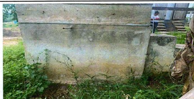
Foto 5: Mejoramiento de Servicios Sanitarios
