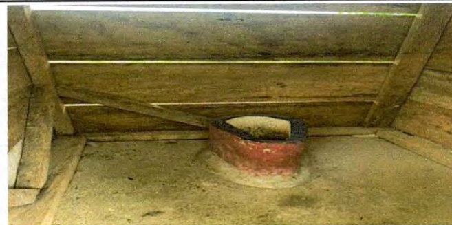
Foto 6: Reparación de piso de torta de cemento por piso alisado de cemento
