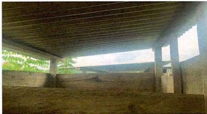
Foto 2: Sustrucción de estructura de madera por metal
