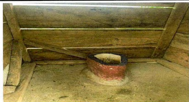
foto 3: Sustrucción de inodoro de abonera seca por inodoro lavable
