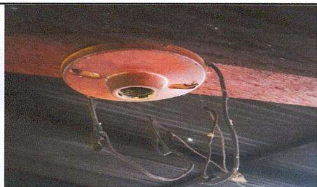
Foto 9: Reparación del sistema eléctrico
