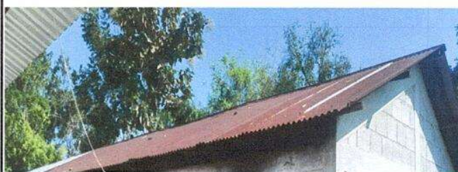
Foto 2: Sustitución de capote de lamina por lamina troquelada
