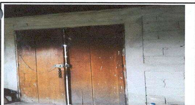
Foto 5: Sustitución de puerta
