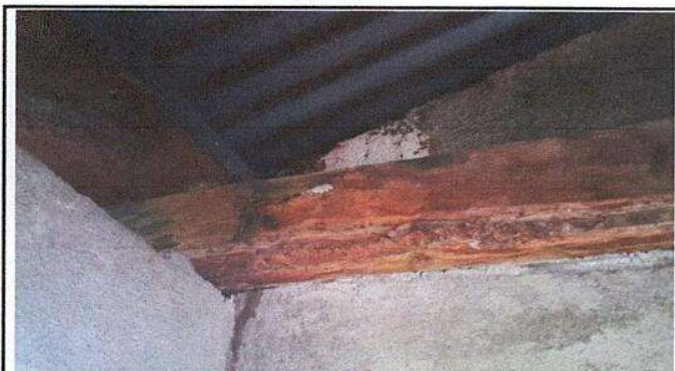
Foto 3: Sustitución de elementos de fijación
