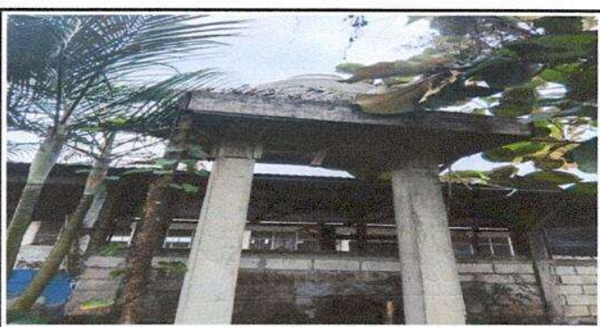
Foto 6: Sustitución de depósito de agua
