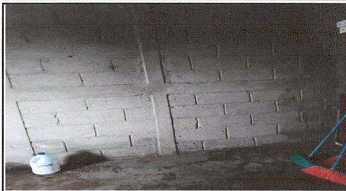
Foto 8: Pintura en muros exteriores e interiores
