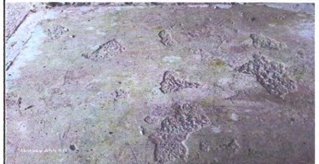
Foto 6: Sustrucción de piso.
