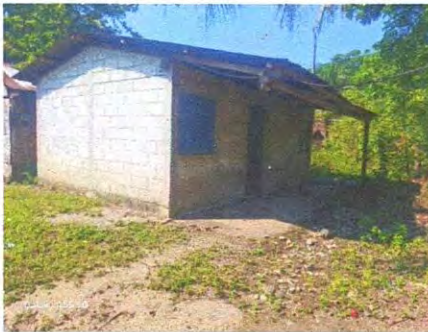
Foto 5: Repello y pintura de paredes de cocina
