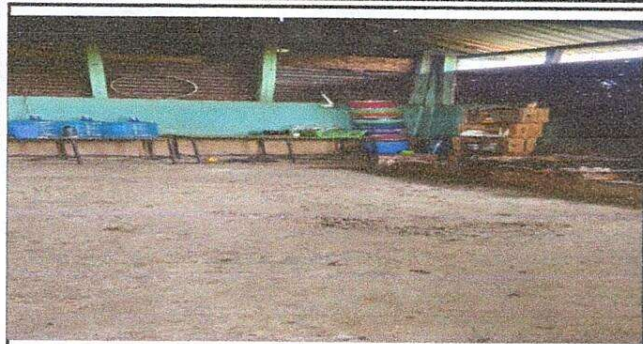
Foto 1: Cambio de piso
