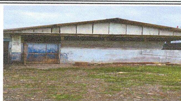
Foto 2: Reparación exterior de cocina
