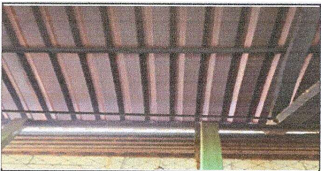
Foto 5: Cambio de estructura y cubierta de láminas
