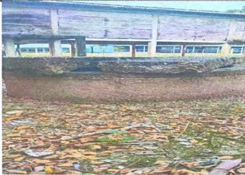
Foto 1: VISTA GENERAL DEL POZO A INTERVENIR
