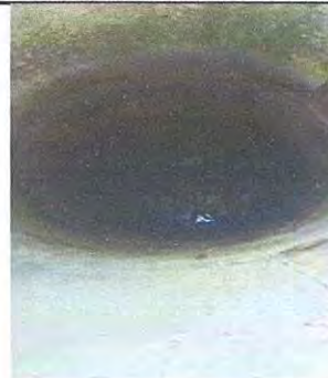
Foto 2: VISTA GENERAL DEL POZO INTERNO.
