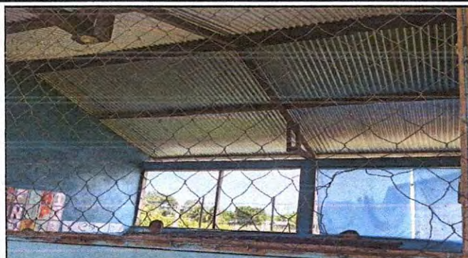
Foto1: SUSTITUCION DE MALLA POR BALCONES DE METAL
