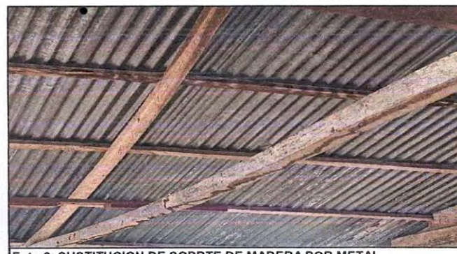
Foto 6: SUSTITUCION DE SOPORTE DE MADERA POR METAL
