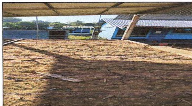
Foto 4: SUSTITUCION DE PISO
