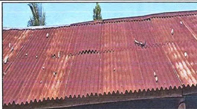
Foto 2: SUSTITUCION DE LAMINAS POR LAMINAS TROQUELADA ALUZINC
