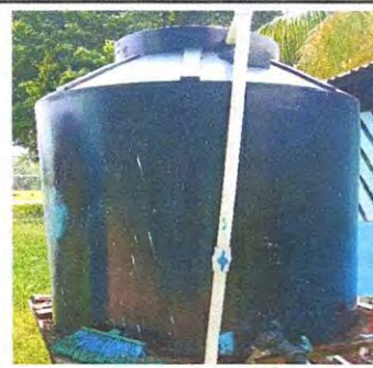
Foto 6: Suministro de deposito de agua.
