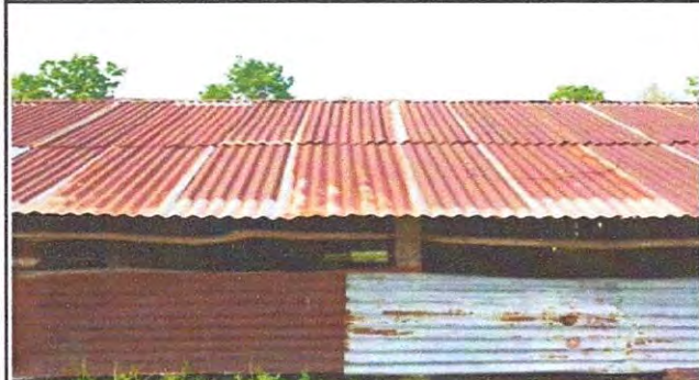
Foto 4: Suministro de paredes.
