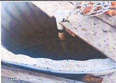
Foto 5: Suministro de tubería principal.
