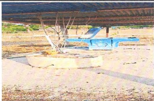
Foto 3: Pozo vista exterior.
