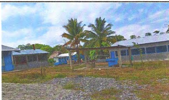
Foto 2: Vista general del establecimiento y pozo.
