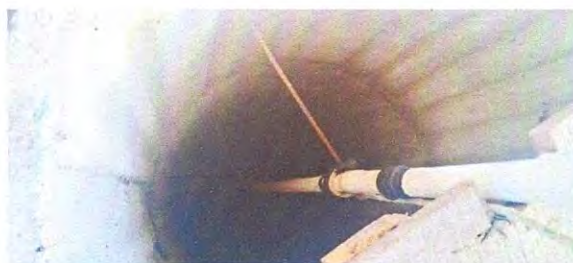
Foto 4: Vista general del pozo interior.
