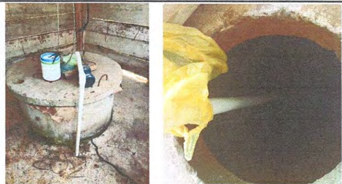
Foto 5: Sistema de tubería y cableado para alimentacion y distribucion de tanque de agua en malas condiciones.
