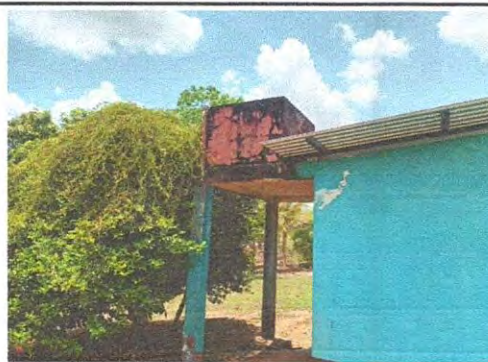
Foto 6: Deposito de agua en pesimas condiciones y sin utilidad.
