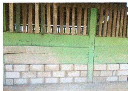
Foto 6: Reparación de muro perimetral de block
