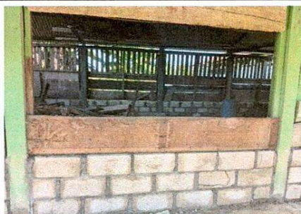
Foto 5: Sustrución de ventana de madera por metal.
