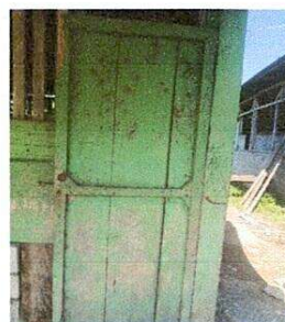
Foto 4: Sustrución de puertas
