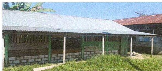
Foto 2: Sustrución de capote de lamina para lamina troquelada
