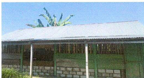
Foto 1 Sustrución de lamina, por lamina troquelada
