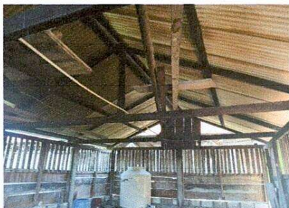
Foto 3: Sustrución de estructura de soporte de madera por metal.
