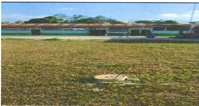
Foto 5: Señalización de lugar para construcción de pozo mecánico
