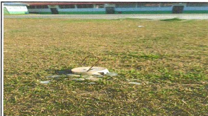
Foto 4: Lugar específico para la construcción de pozo mecánico
