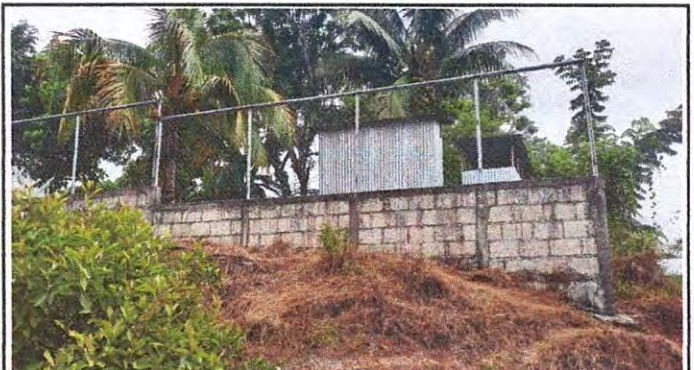
Foto 4: Reparación de columnas dañadas
