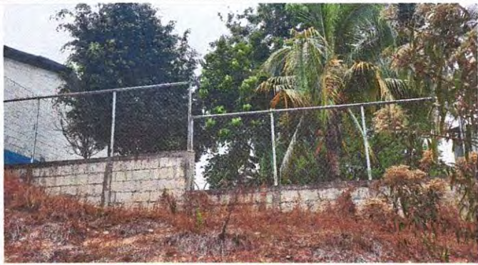
Foto1: Reparación de Block dañado por block nuevo
