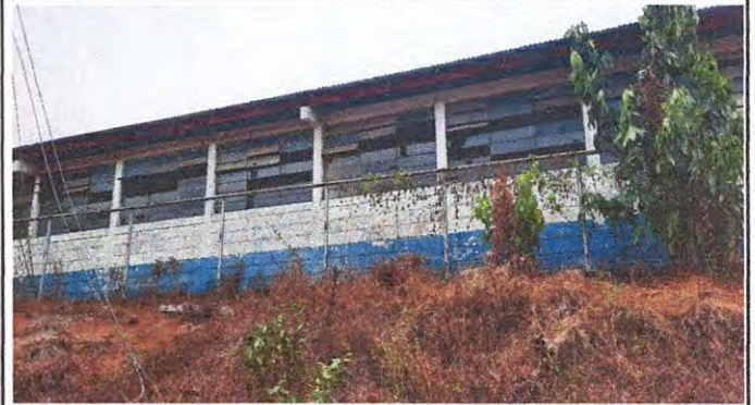
Foto 2: Reparación de malla dañado por malla nueva
