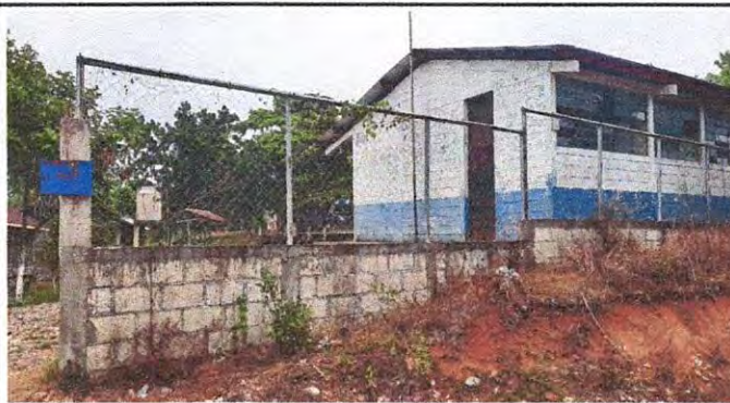
Foto 3: Reparación de tubo dañado por tubo nuevo
