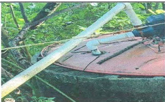
Foto 3: sustitucion de cableado electrico
