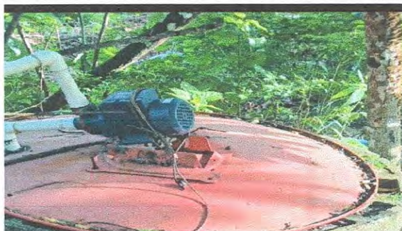
Foto 2: sustitucion de bomba de agua
