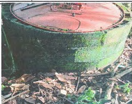
Foto1: Mejoramiento de pozo artesanal a pozo mecanico
