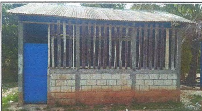
Foto 4: Construcción de horcon para corredor de concreto
