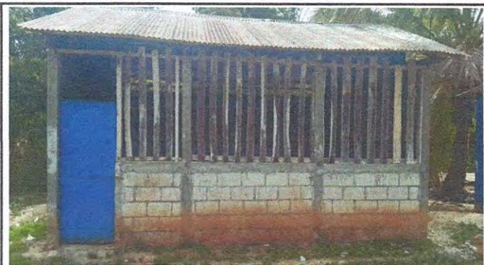
Foto1: Sustrucion de lamina, por lamina troquelada aluzinc calibre 26
