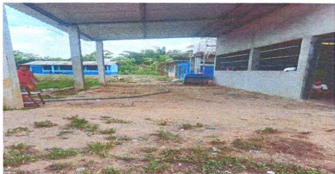
Foto 1: Reparación de piso de torta de concreto
