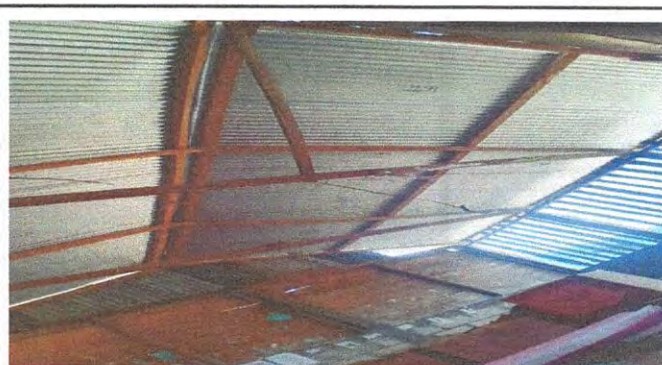
Foto 4: Sustrucion de estructura de soporte de madera, por metal
