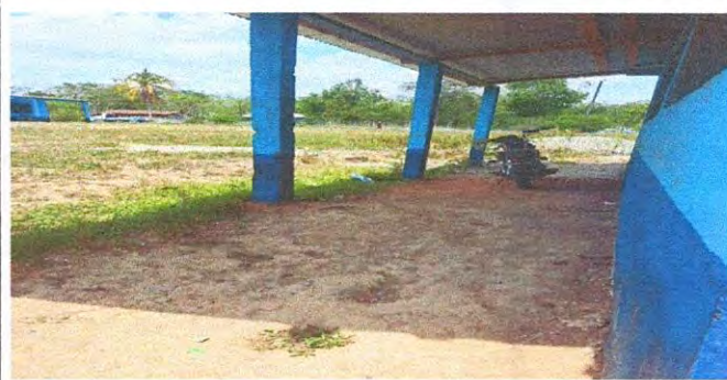
Foto 2: Reparación de piso de torta de concreto
