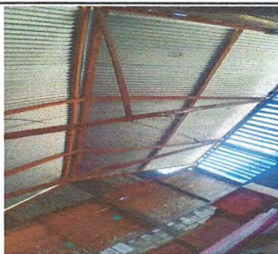
Foto 5: Sustitución de costaneras de madera por metal y tijeras de metal
