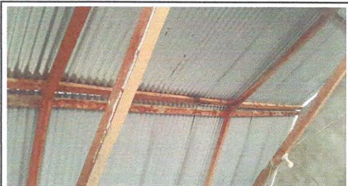
Foto 3: Sustrucion de estructura de soporte de madera, por metal
