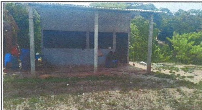
Foto 3: Cambio de piso de tierra a piso de torta de cemento
