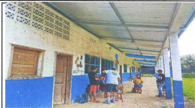
Foto 1: VISTA GENERAL DEL ESTABLECIMIENTO A INTERVENIR.
