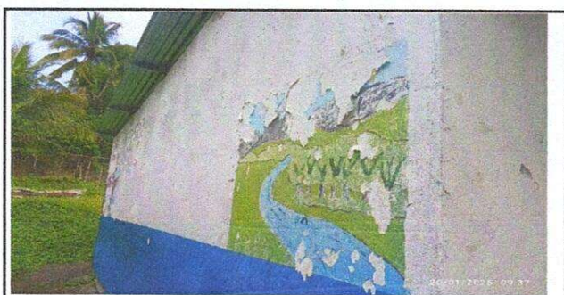
Foto 5: PINTURA EN PAREDES EN MUY MAL ESTADO.
