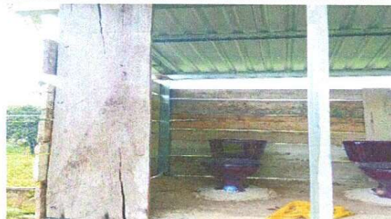
Foto 6: SUMINISTRO DE LAVAMANOS Y MINGITORIOS.
