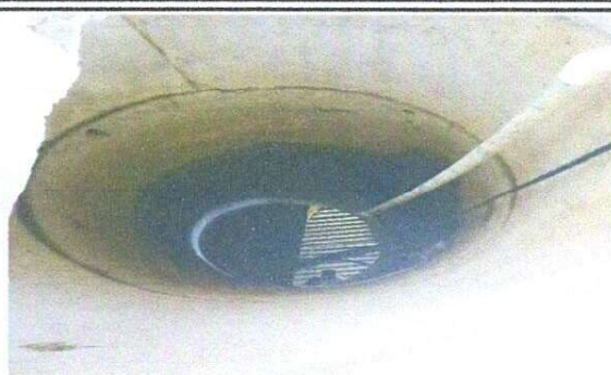
Foto 2: MEJORAMIENTO DE POZO ARTESANAL POR POZO MECÁNICO.
