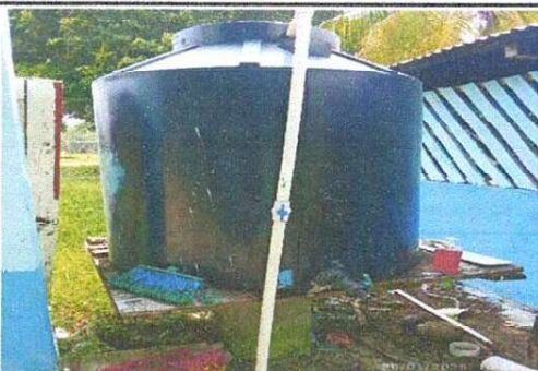
Foto 3: SUSTITUCION DE DEPOSITO DE AGUA.
