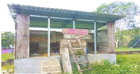
Foto 5: SUMINISTRO DE PAREDES PARA SERVICIOS SANITARIOS.
