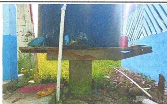
Foto 4: SUMINISTRO DE TORRE DE METAL Y TUBERIA PRINCIPAL DE PVC.
