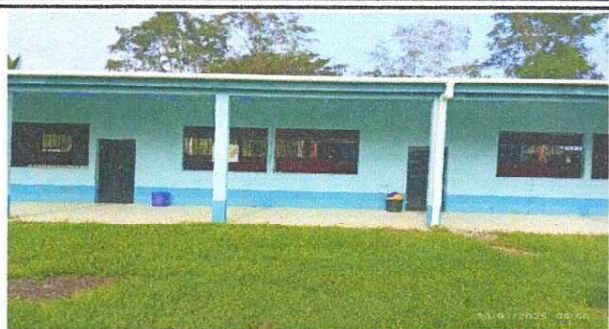
Foto 1: VISTA GENERAL DEL ESTABLECIMIENTO A INTERVENIR.
