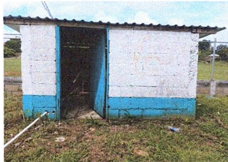
Foto 2: Casa del pozo
