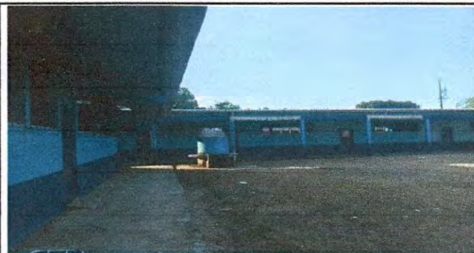
Foto 1: Tanque de distribución de agua en mal estado
