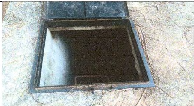
Foto 5: abertura de pozo
