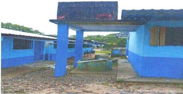
Foto 3: SUMINISTRO DE DEPOSITO DE AGUA.
