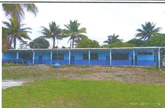
Foto 1: VISTA GENERAL DEL ESTABLECIMIENTO A INTERVENIR.
