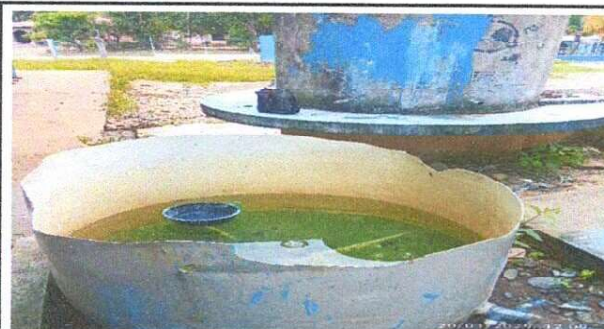
Foto 6: SUMINISTRO DE LAVAMANOS
