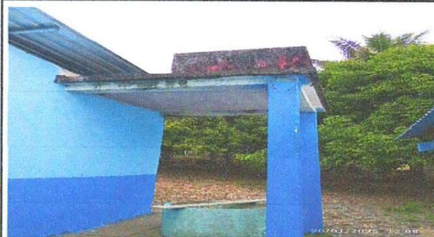
Foto 4: SUMINISTRO DE TUBERÍA PRINCIPAL PARA POZO, PILA Y LAVAMANOS.
