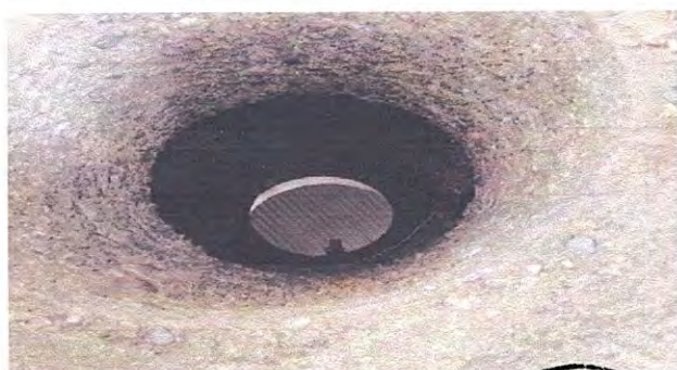
Foto 5: abertura de pozo
