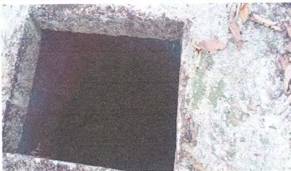
Foto 3: VISTA GENERAL DEL POZO A MEJORAR.
