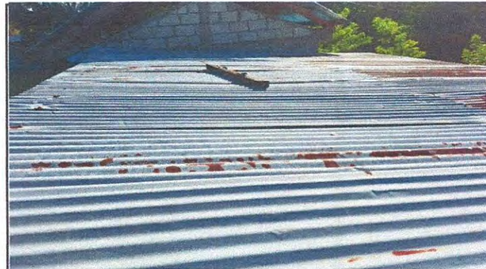
Foto 4: Sustitución de lámina de zinc por lamina troquelada
