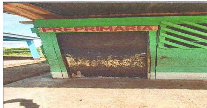
Foto 6: Sustitución de puerta d madera por metal
