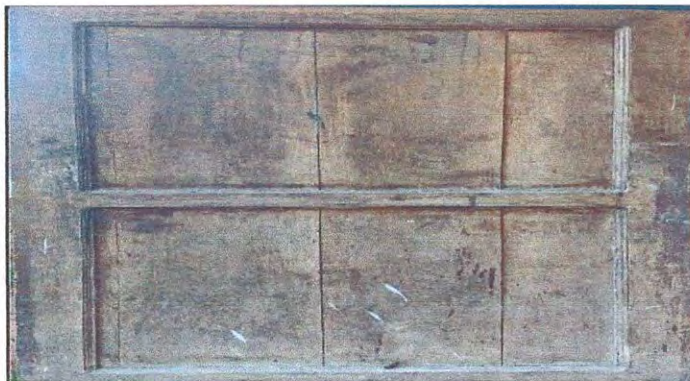
Foto 3: Sustitución de puerta de madera por metal
