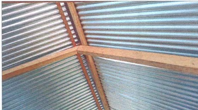
Foto 2: sustitución de bigas de madera por costaneras de metal
