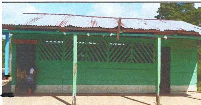
Foto 5: Sustitución de ventanas de madera por balcones de metal
