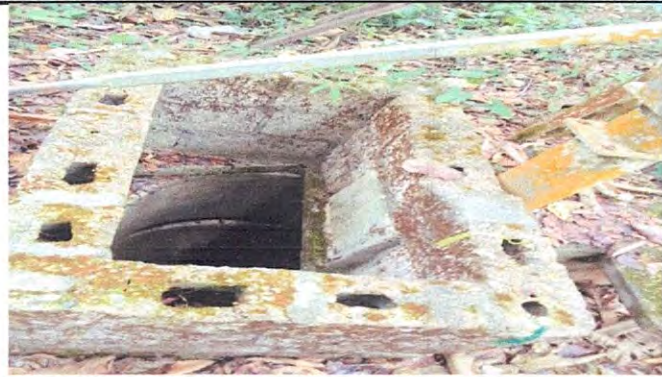
Foto 2: Vista interior del pozo.
