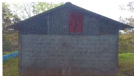
Foto 4: ESTADO ACTUAL DE LA PARTE DE ATRÁS DE COCINA
