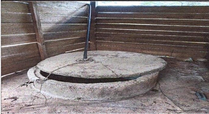
Foto1: sustitución de pozo artesanal a pozo mecánico
