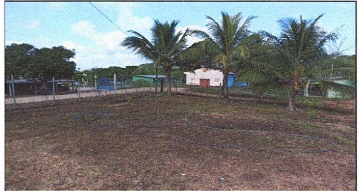
Foto 2: sustitucion de Cableado
