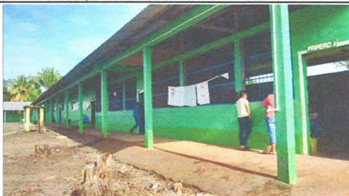
Foto 2: Cambio de color de pintura en pared exterior.
