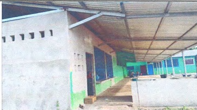
Foto1: Completar y cambio de color de pintura en pared exterior.
