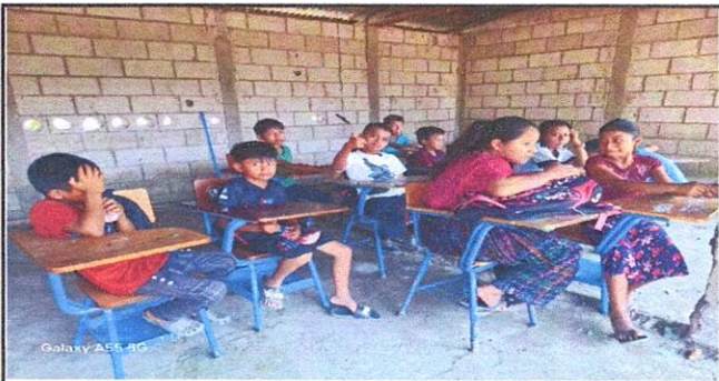
Foto 5: Reparación y repello de aulas.
