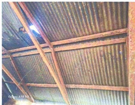
Foto 2: Sustrucción de estructura de madera por estructura de metal.
