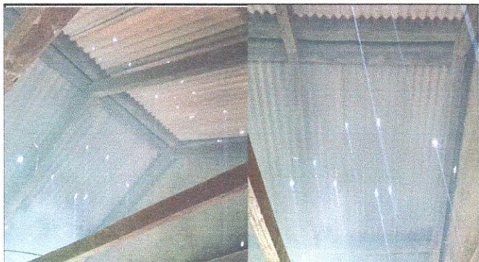
Foto1: lámina deteriorada
