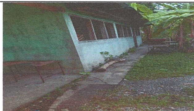
Foto 6: Vista frontal cocina escolar
